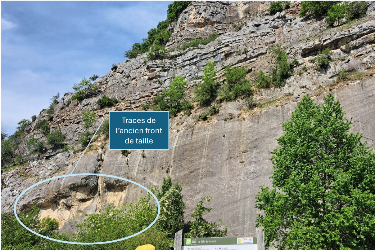
Ancien front de taille de l'ancienne carrière « sauvage »
